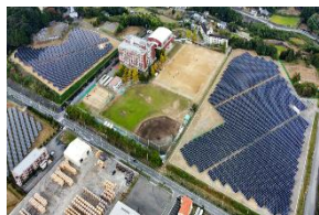
南海小峰台太陽光発電所
